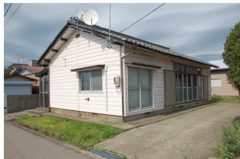
多少の修繕により住宅として使用できる建物です。
